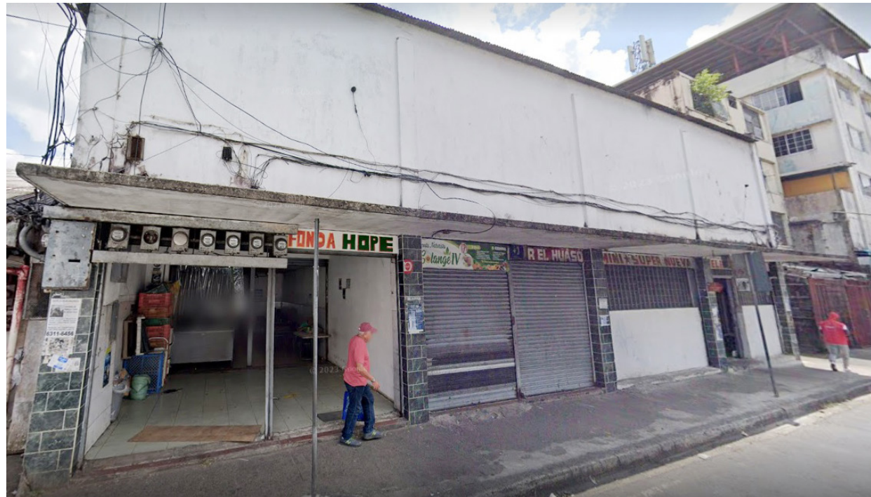
Antigua estructura del Teatro Presidente ubicado en la avenida Perú y Calle P.
