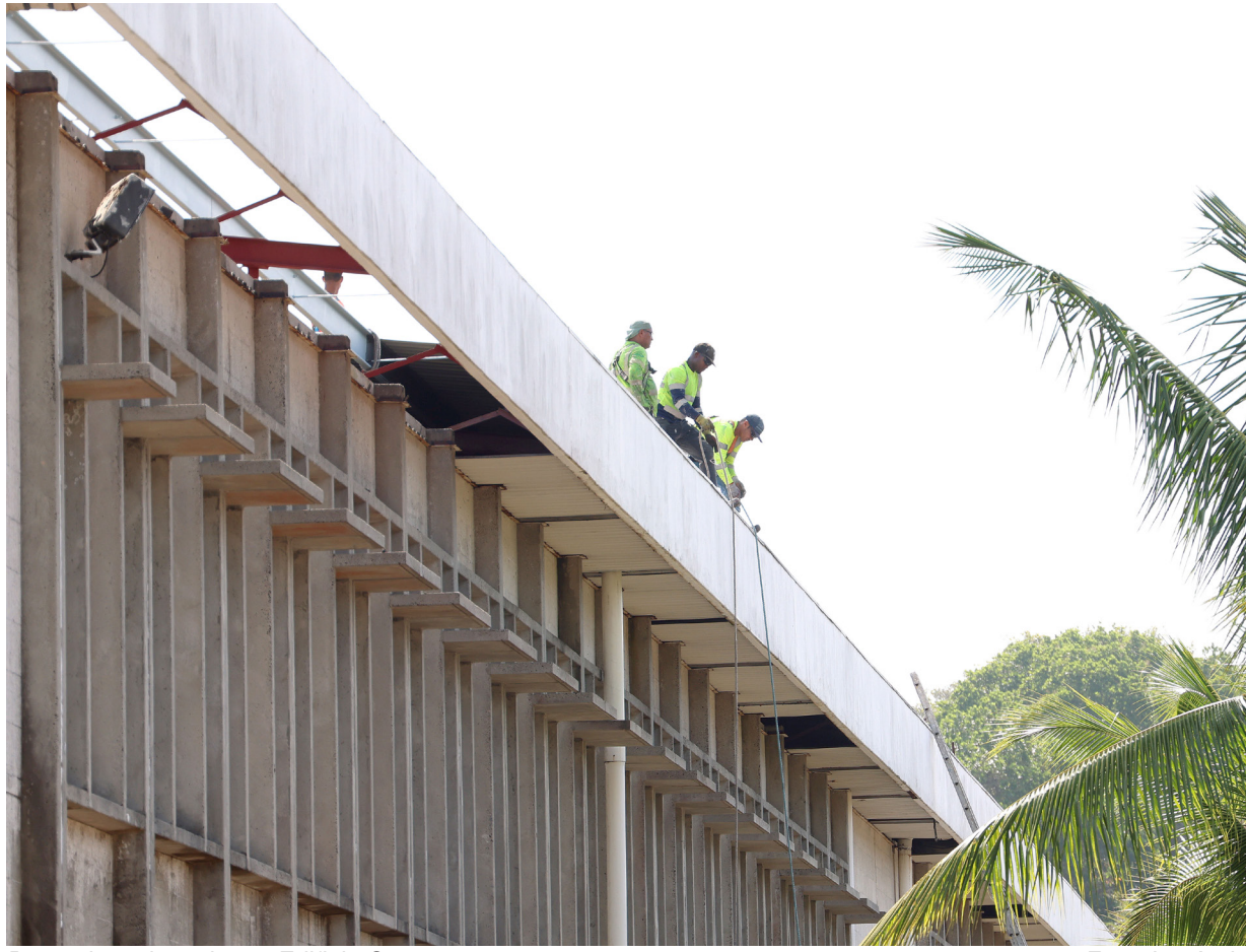
Reemplazo de techo en Edificio C.
