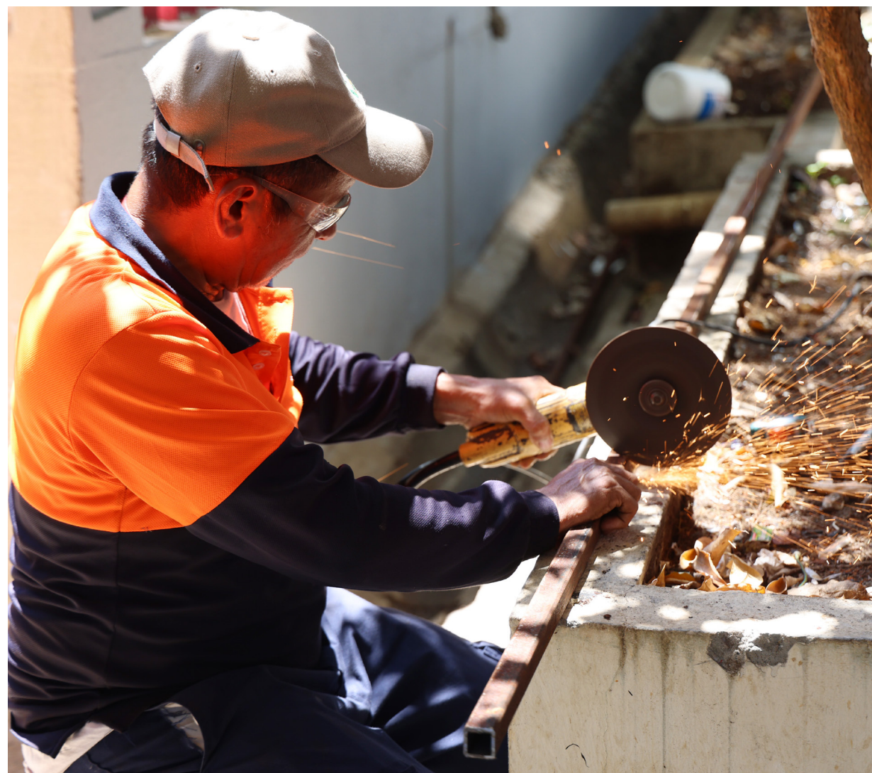
Funcionario de la UP en labor de soldadura.
