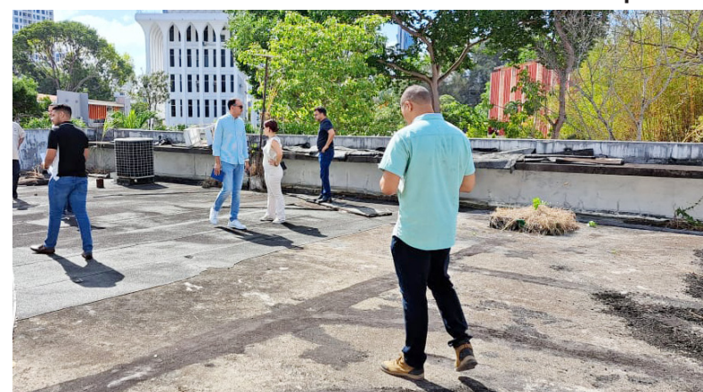
Representantes de las empresas interesadas en la licitación supervisan la azotea del edificio de la Escuela de Biología.
