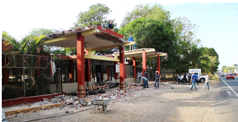
Demolición de losa, parte frontal a la calle Polidoro Pinzón.
