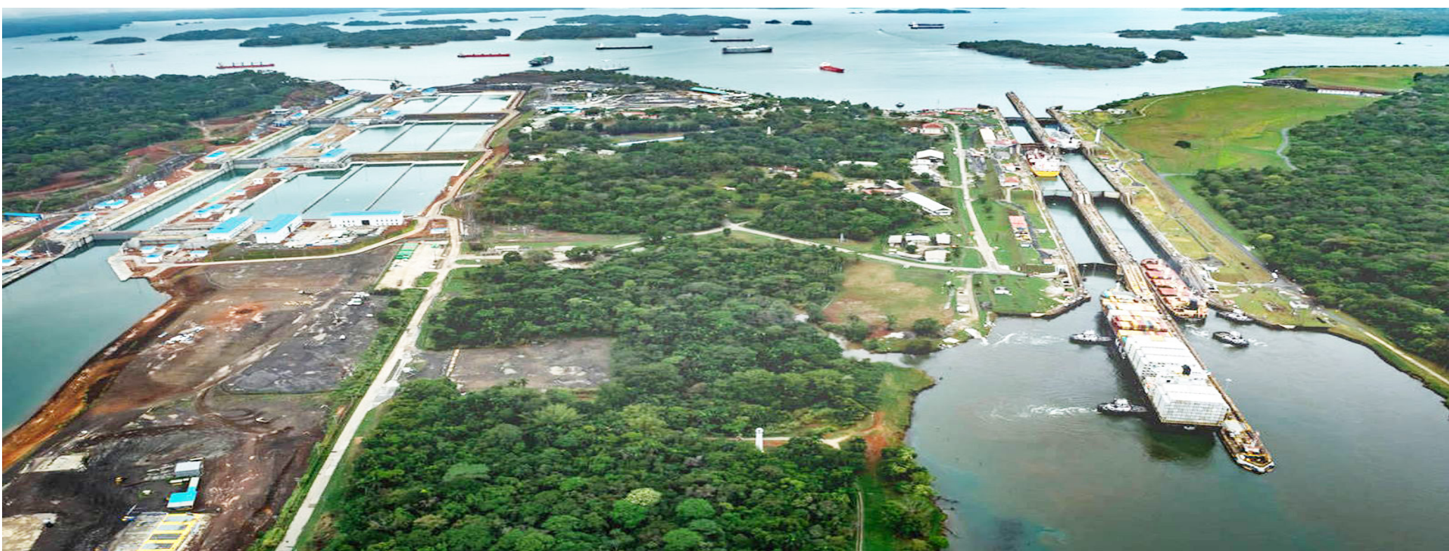
Vista panorámica de la ampliación del Canal y las antiguas esclusas.
