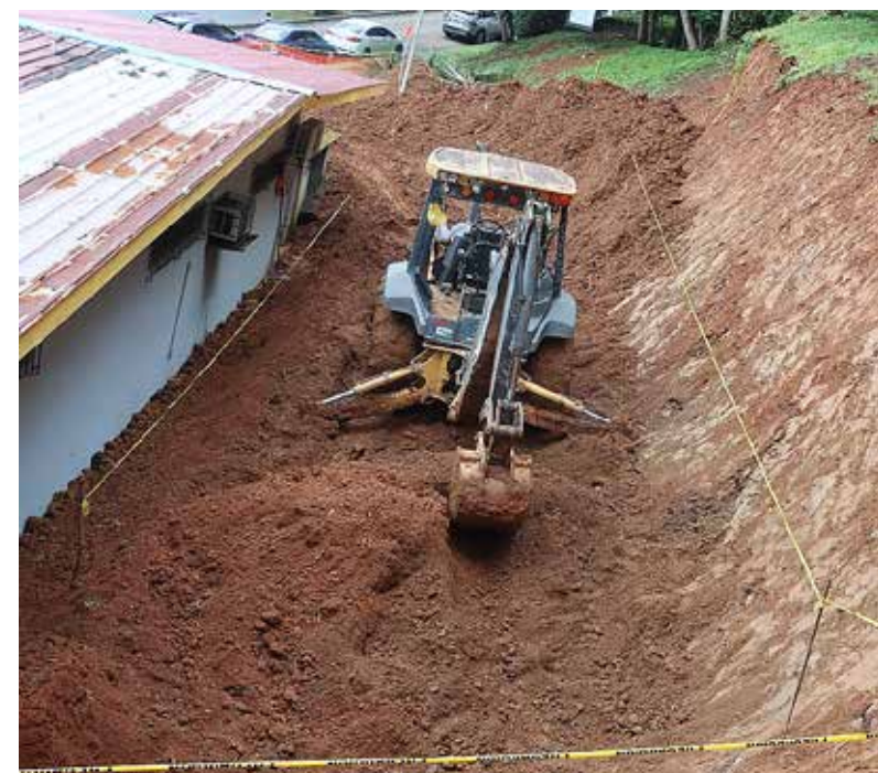
Preparación de la ladera del cerro y remoción de tierra.
