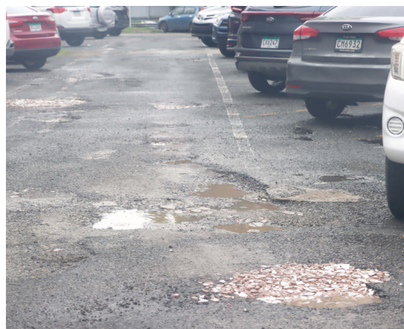
Estacionamiento de los edificios Los Gemelos.
