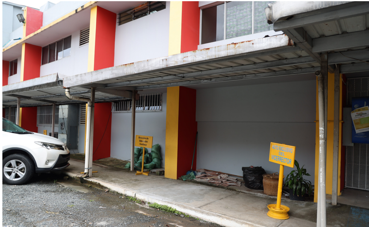
Marquesinas a ser restauradas.
