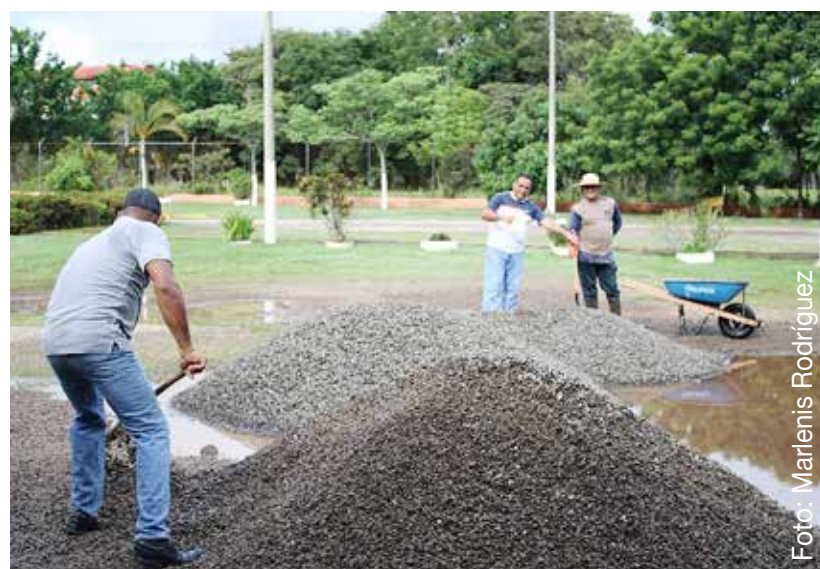
Personal de la unidad procede a regar las piedras para rellenar los huecos.
