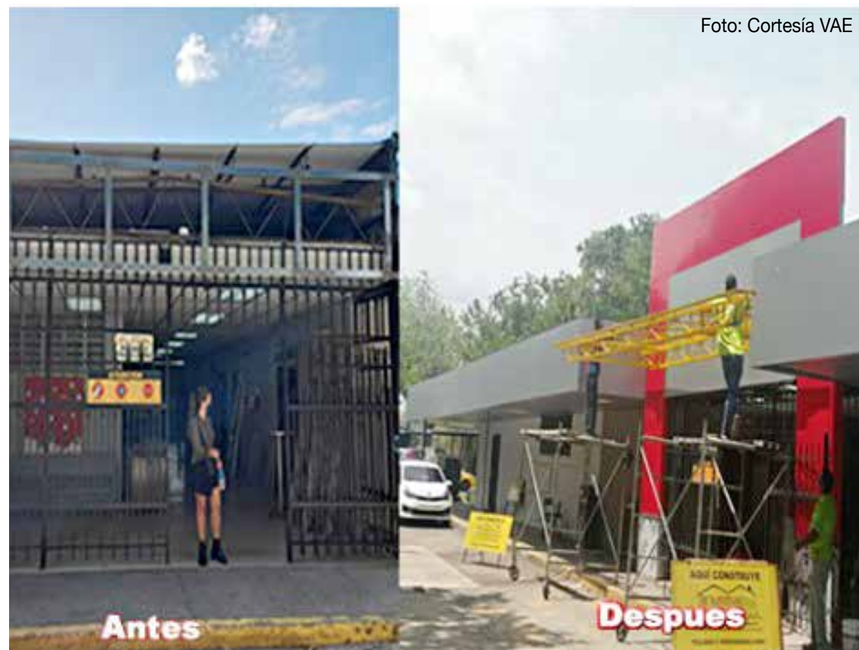
Trabajos de remodelación en el Gimnasio Universitario.
