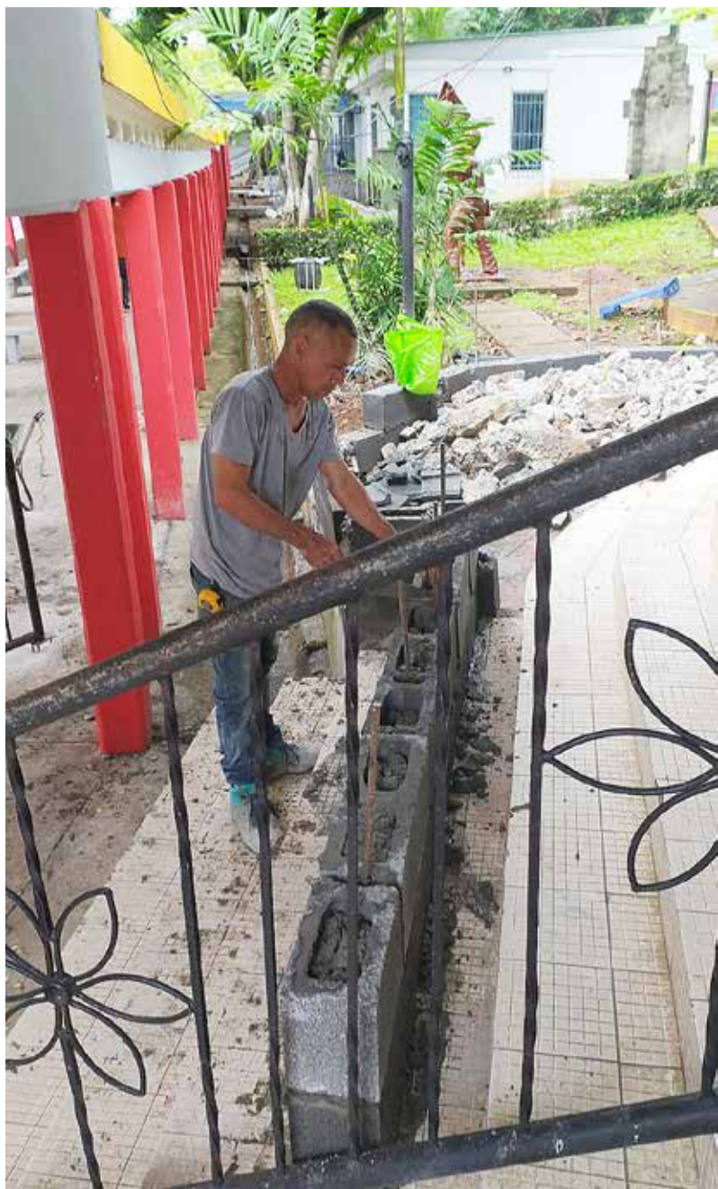
Trabajo de rehabilitación de rampa y escalera.
