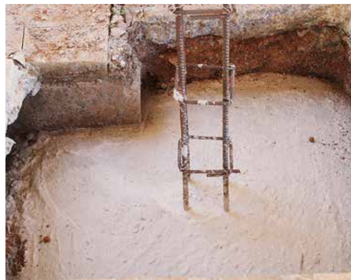
Excavación profunda para cimientos nuevos.
