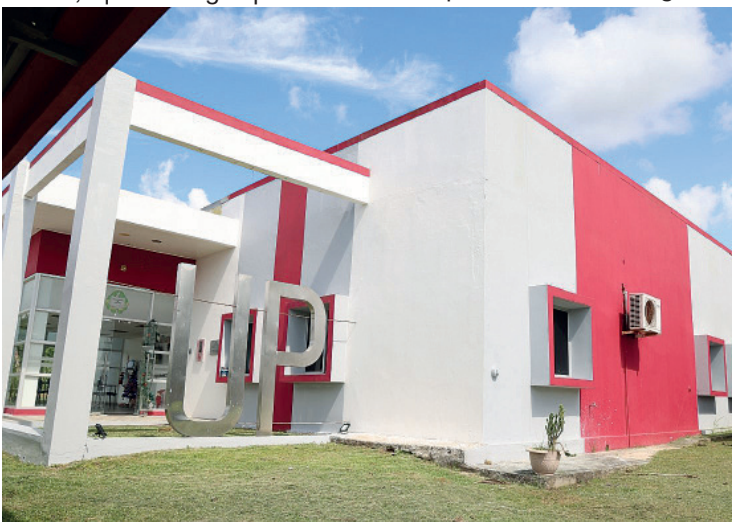
Instalaciones del Cidete del Centro Regional Universitario de Panamá Oeste.
