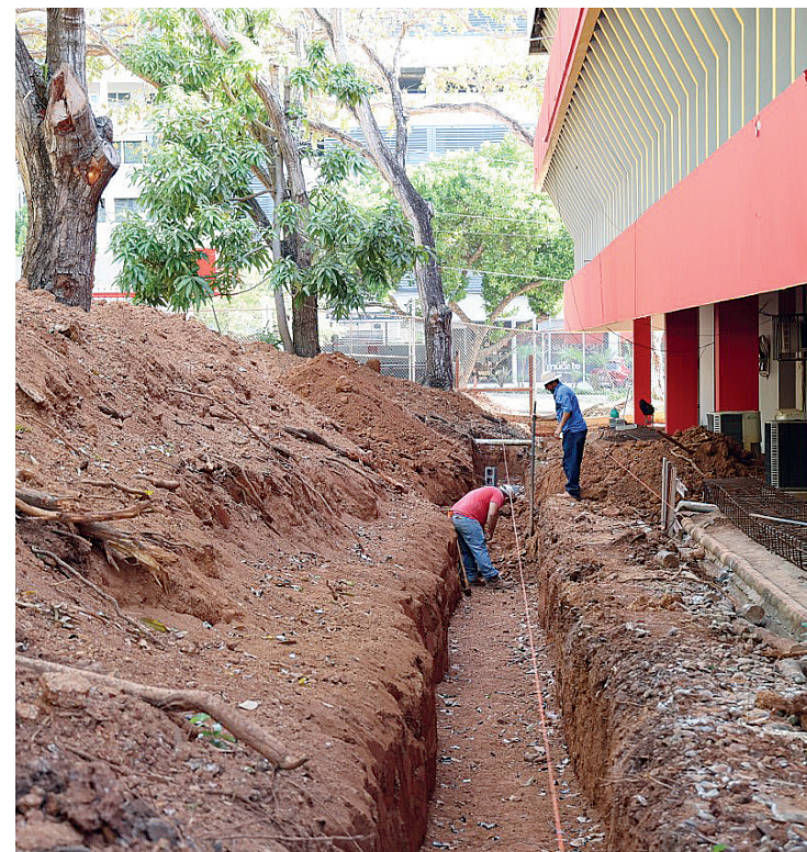
Excavación del muro perimetral en la Facultad de Informática.
